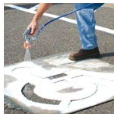
Нанесение разметки с помощью трафарета
